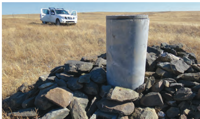
Reservatório do tipo manilha.
